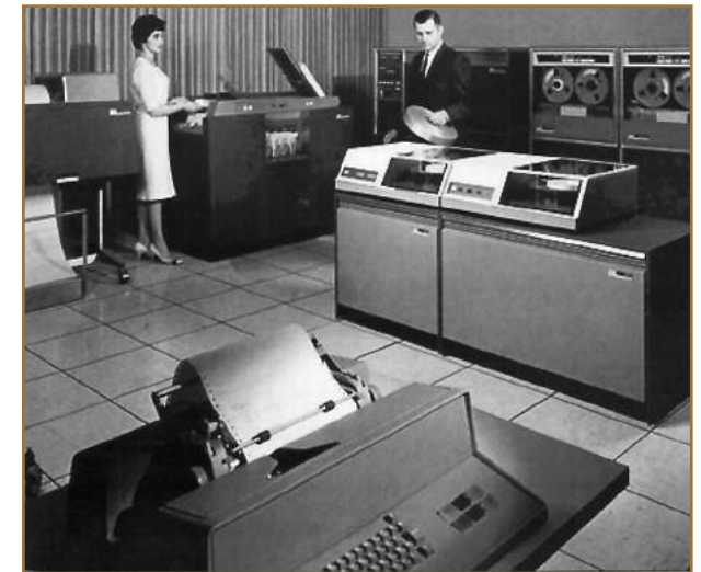
Abb. 2: Rechenzentrum mit halbhohen Plattenspeichern. Der Operator hält eine Wechselplatte in der Hand. (Foto IBM)
