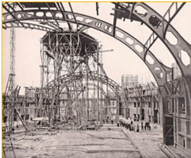
Montage des Druckrings und der Tonnenbinder im Mai 1908
