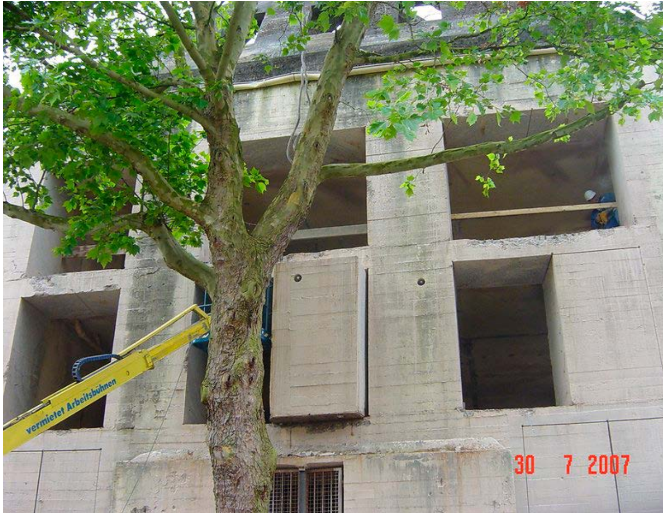
Bild 12: Heraussägen von Fensteröffnungen
