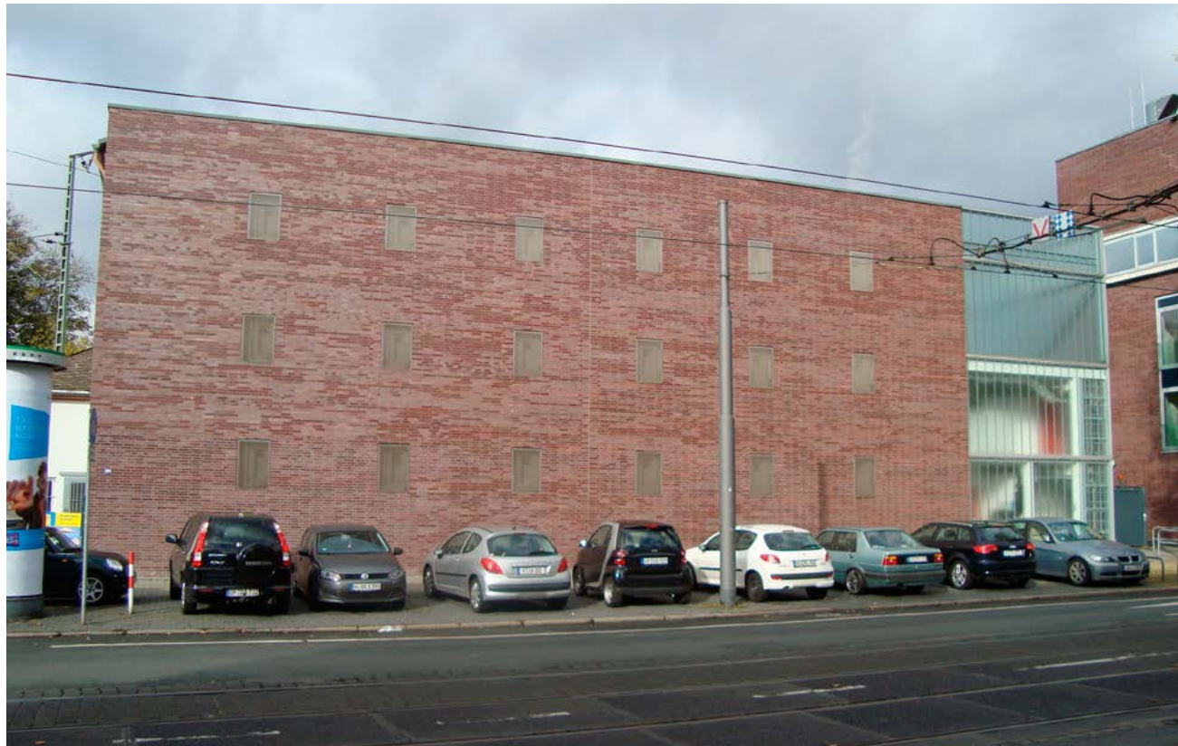
Bild 4: Bunker Nr. 42 – Sachsenhausen/Mörfelder Landstr.
