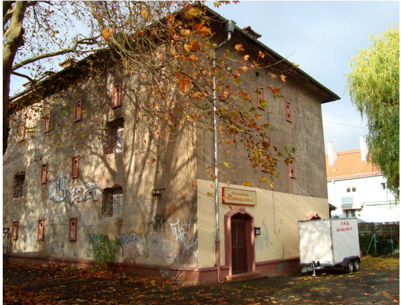
Bild 11: Bunker Nr. 39 Riederwald/Engelsplatz
