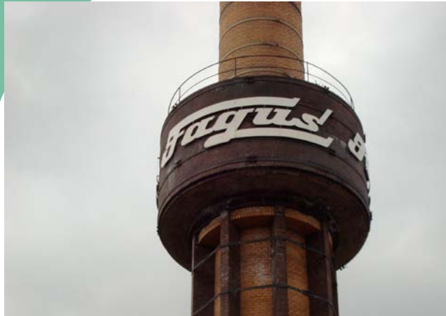
Bild 3: Intze Behälter am Kamin der Fagus Werke (Foto: K.H. Steiner)
