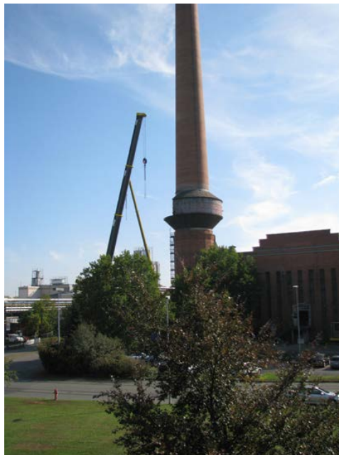
Bild 2a und b: Abriss Intze-Behälter Allessa Kraftwerk
