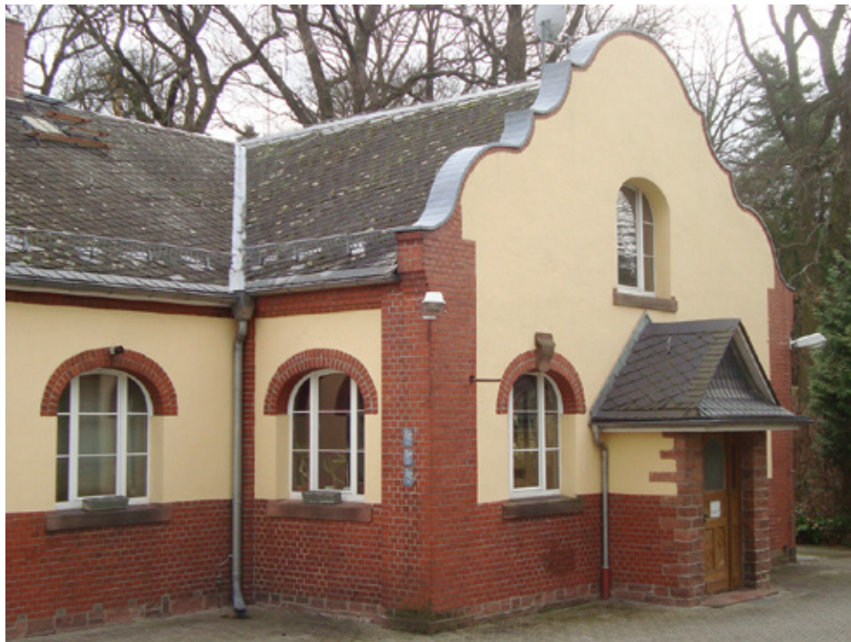
Bild 3: Pumpengebäude im Wasserpark an der Friedberger Warte (K. H. Steiner)
