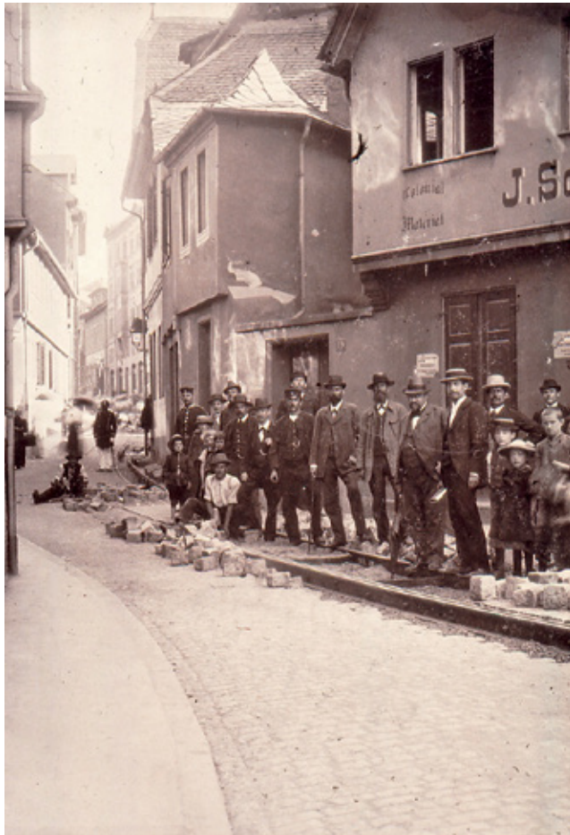
Verlegung der Schienen für die elektrische Straßenbahn in der Kirchstraße, 1897
