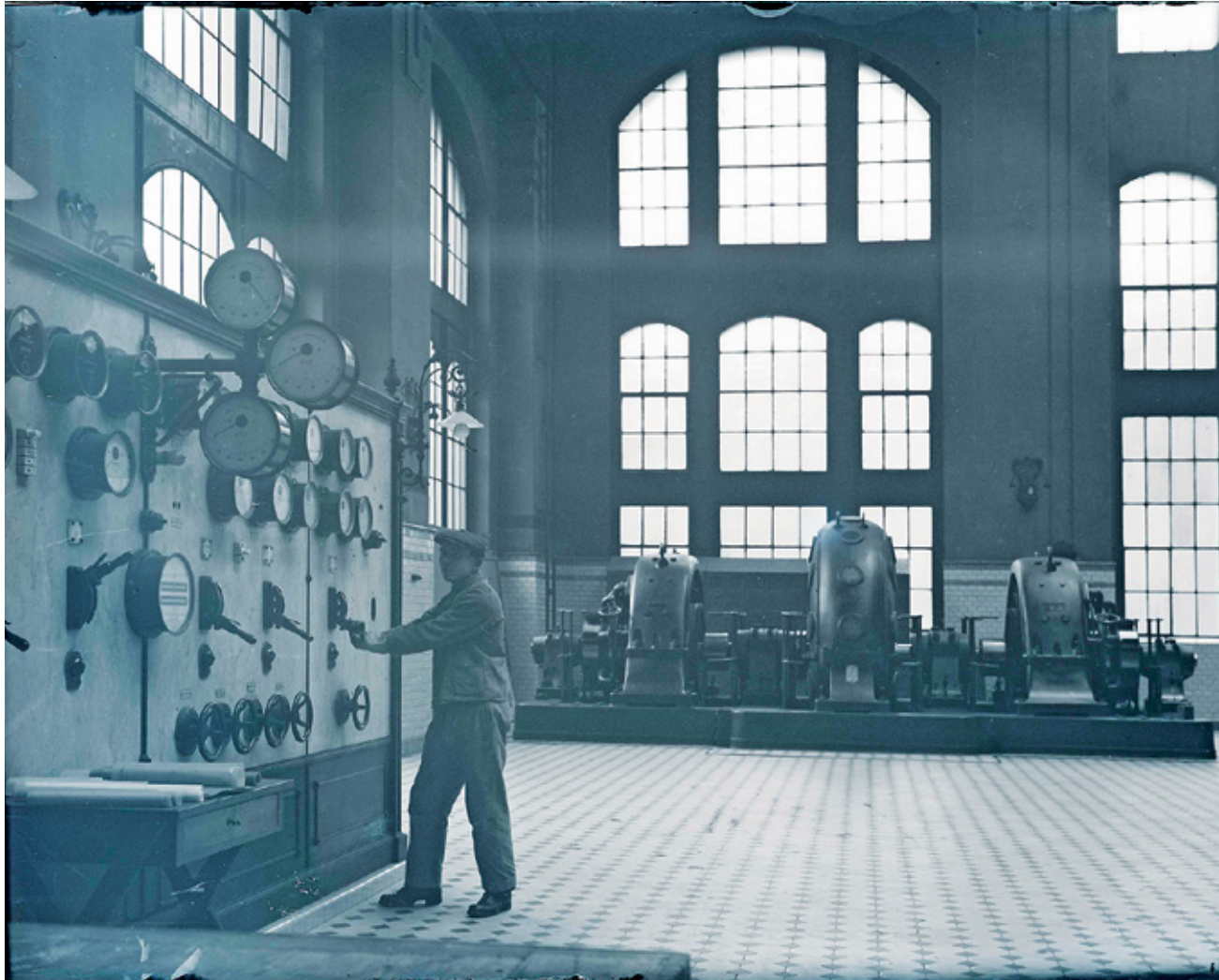
Schalttafel im Maschinenhaus des erweiterten Elektrizitätswerks an der Schuchardstraße (heute Centralstation), 1905
