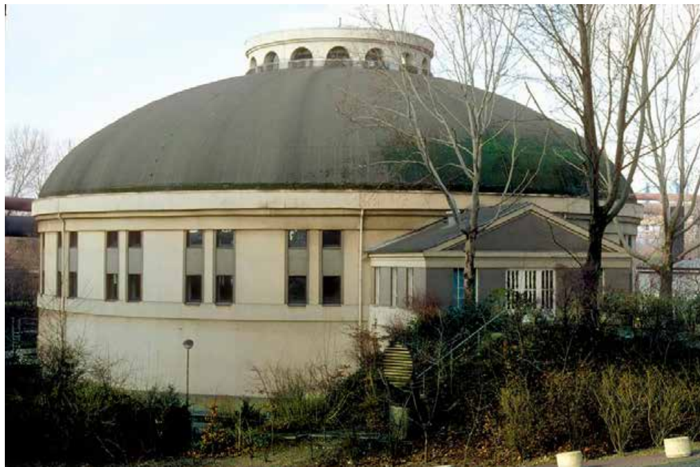
Pumpwerk Alte Emscher in Duisburg
