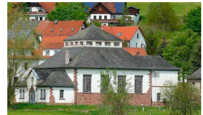
Wasserwerk in Mernes
