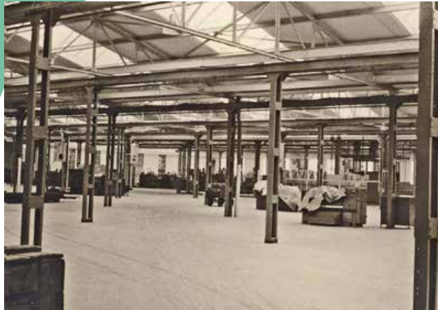
Die Hallen mussten komplett saniert werden
