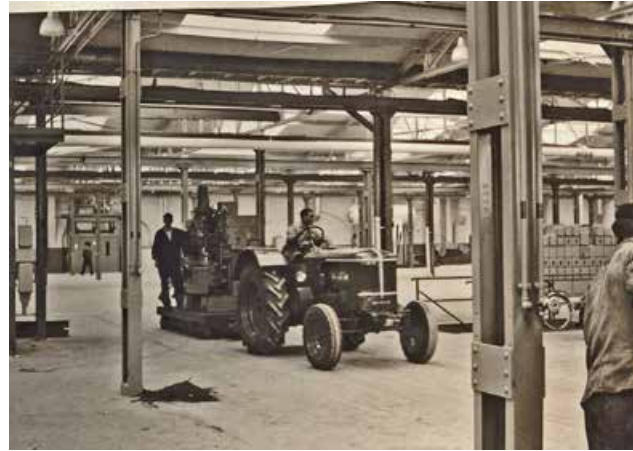
Die ersten Maschinen wurden aufgestellt
