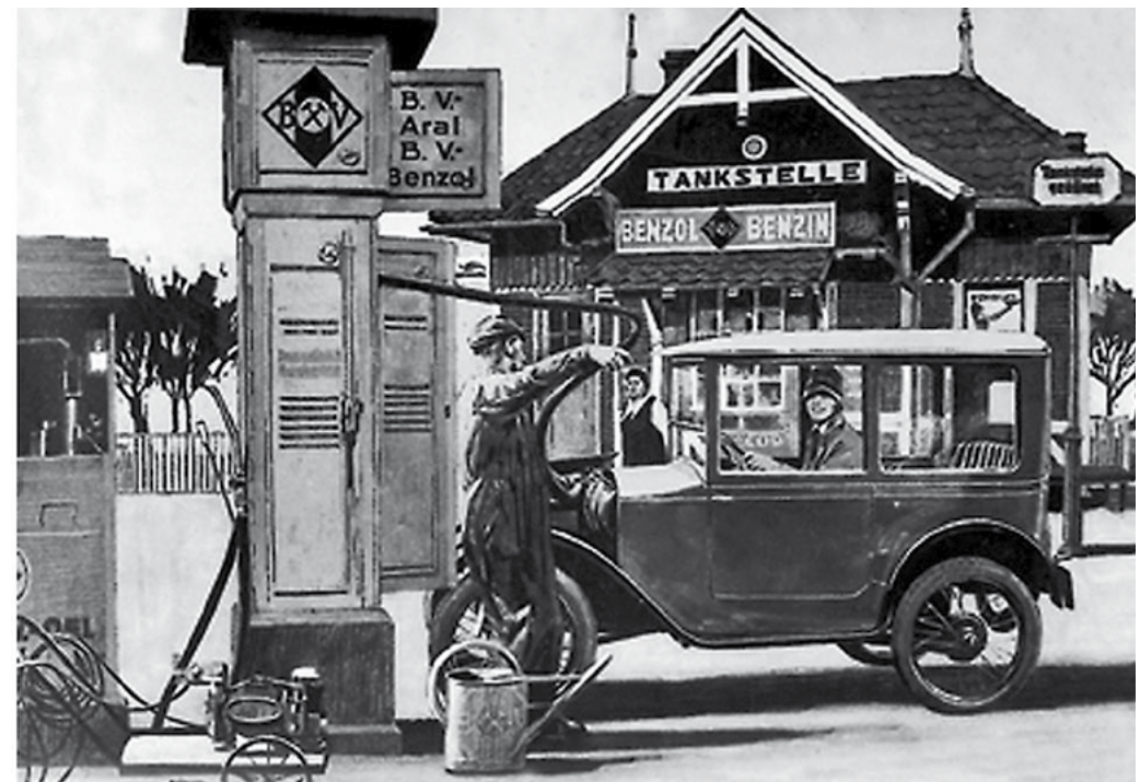
Tankstelle der 1920'er Jahre
