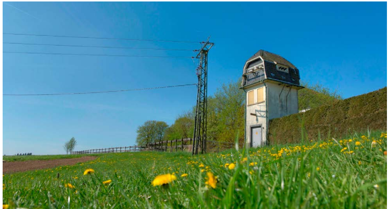
Von 1913 bis 2010 versorgte das Trafohäuschen in Herweg (zwischen Hückewagen und Radevormwald) die Menschen mit Strom.
