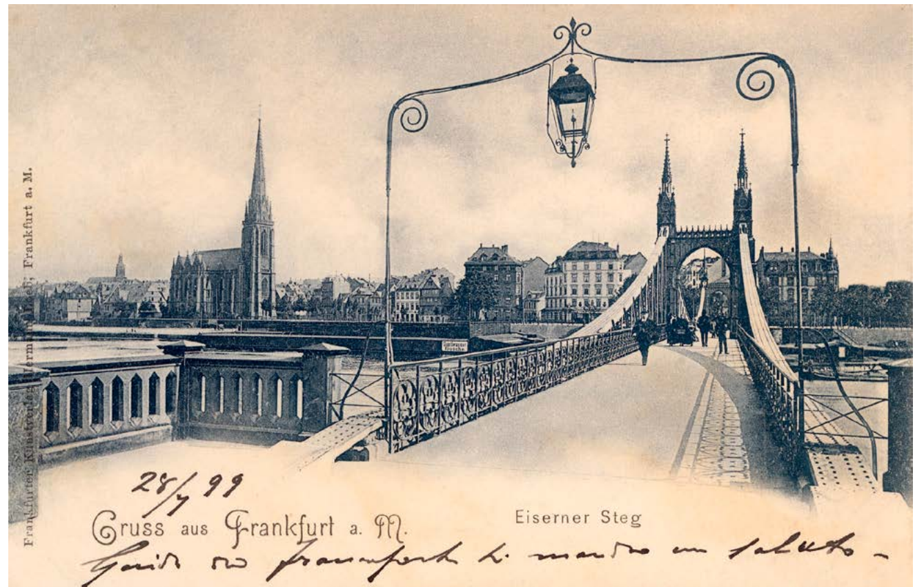
Bild 3: Beleuchtung des Eisernen Steges mit Gaslicht
