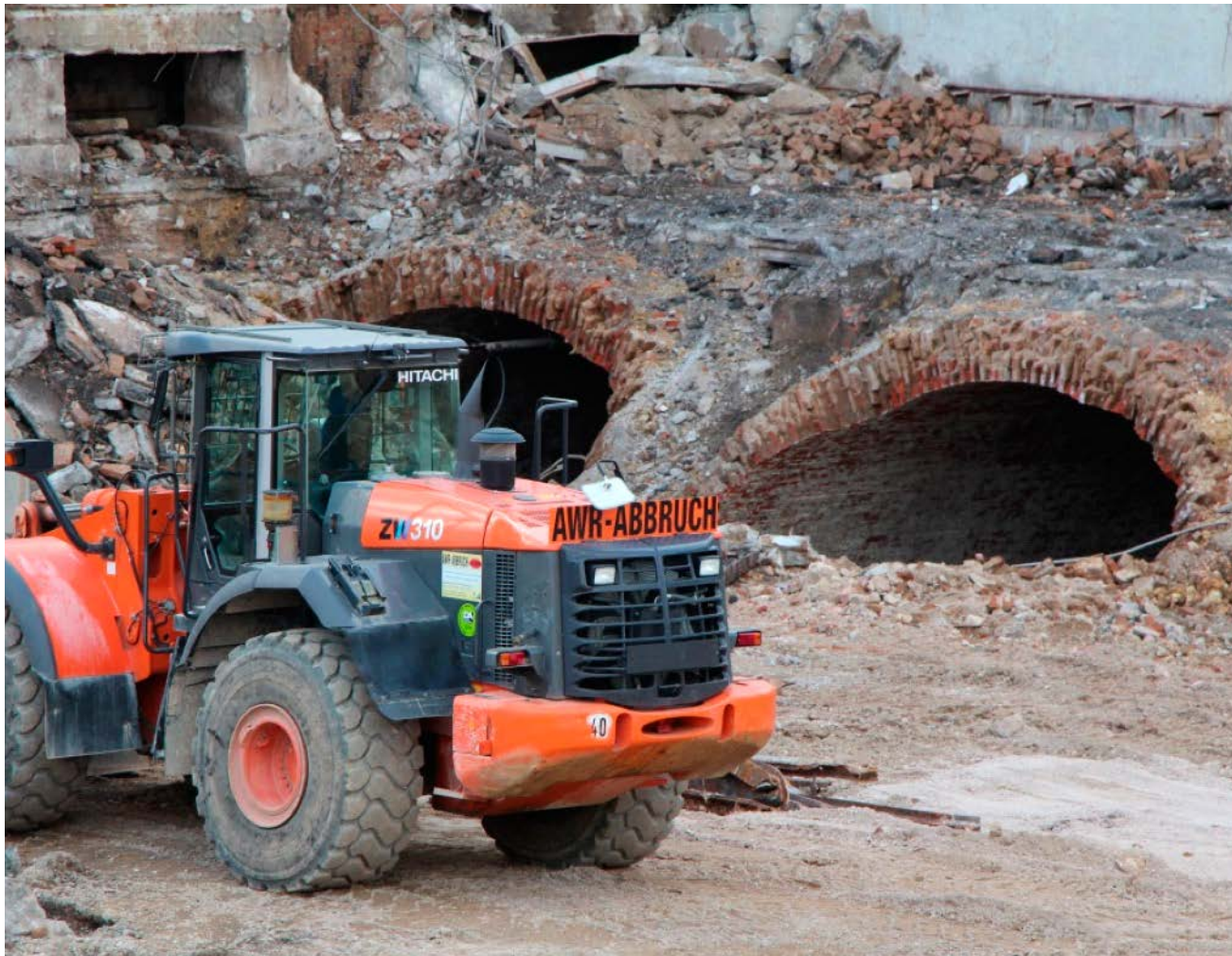
Baugrube Henninger-Turm-Wohnhaus mit Brauereikeller-Fragmenten (Foto: K.H. Steiner)
